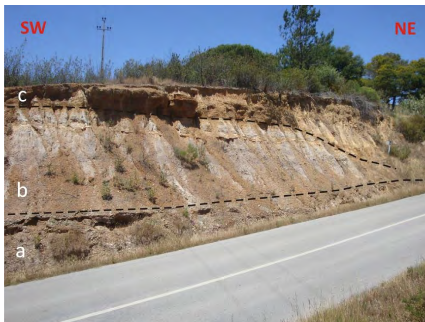
Figura 3.9 – Afloramento na estrada N261-2, junto a Melides (figura 3.1, 2; 38°9'14'' N/8°42'48'' W), mostrando a formação de Melides. As linhas separam os três corpos sedimentares principais referidos no texto.
